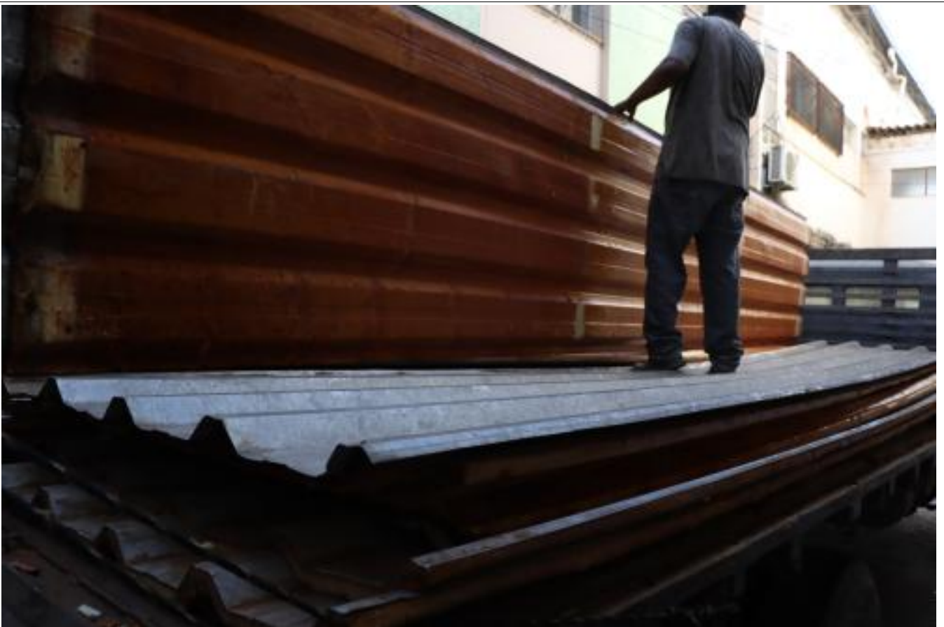
Troca de telha
