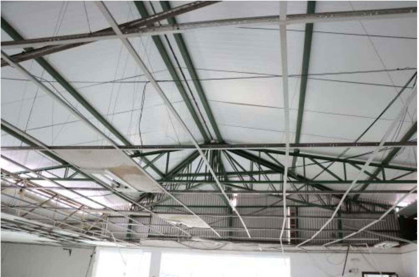
Colocacao de telhas novas
