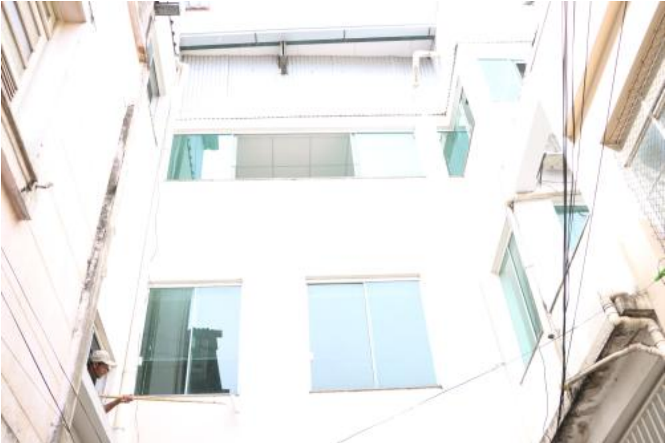
pintura acrílica e emassamento de parede
