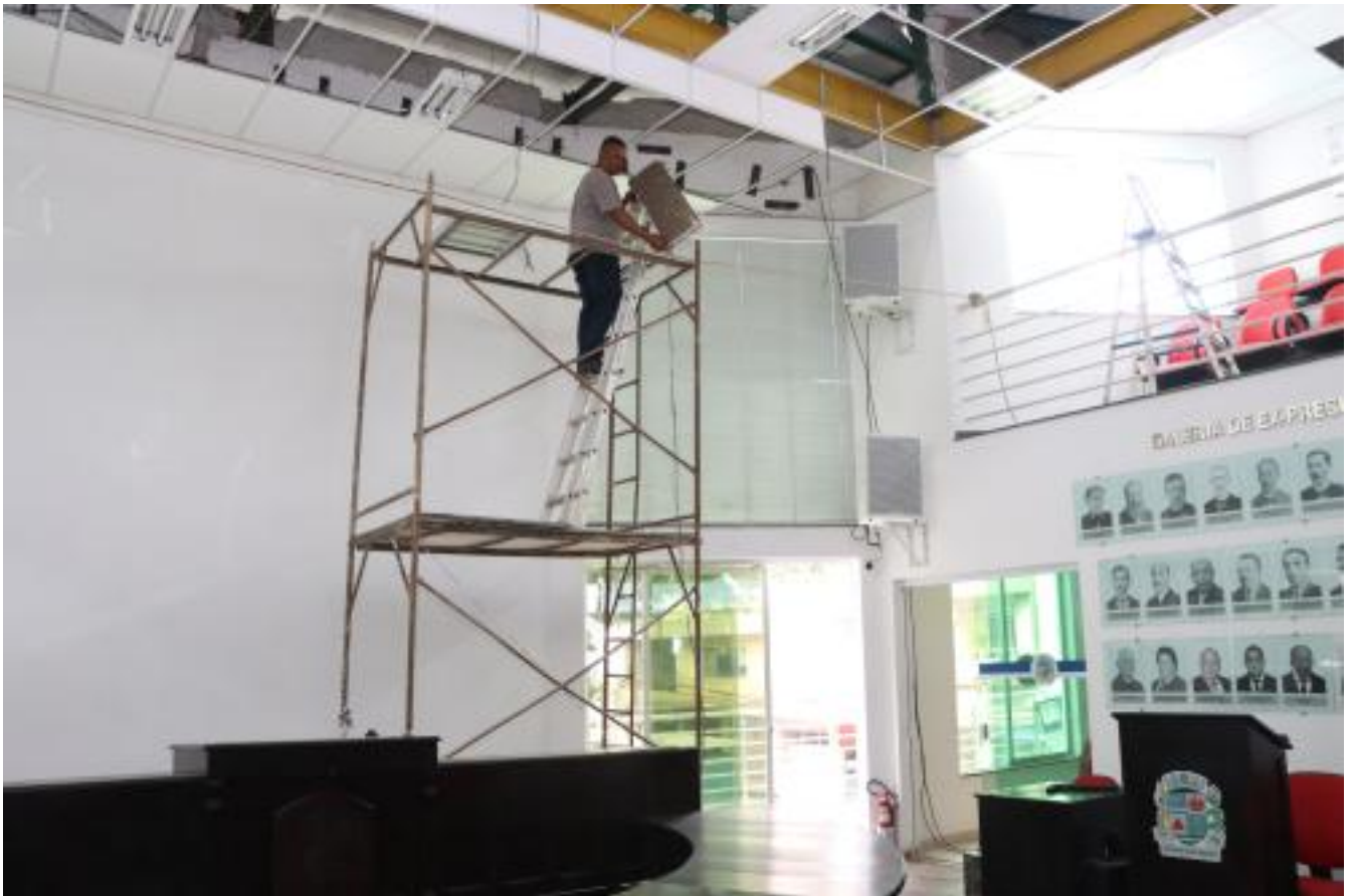
andaime metalico; remocao de luminaria e forro
