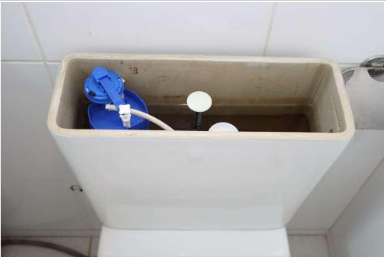
instalação de mecanismo reparo
