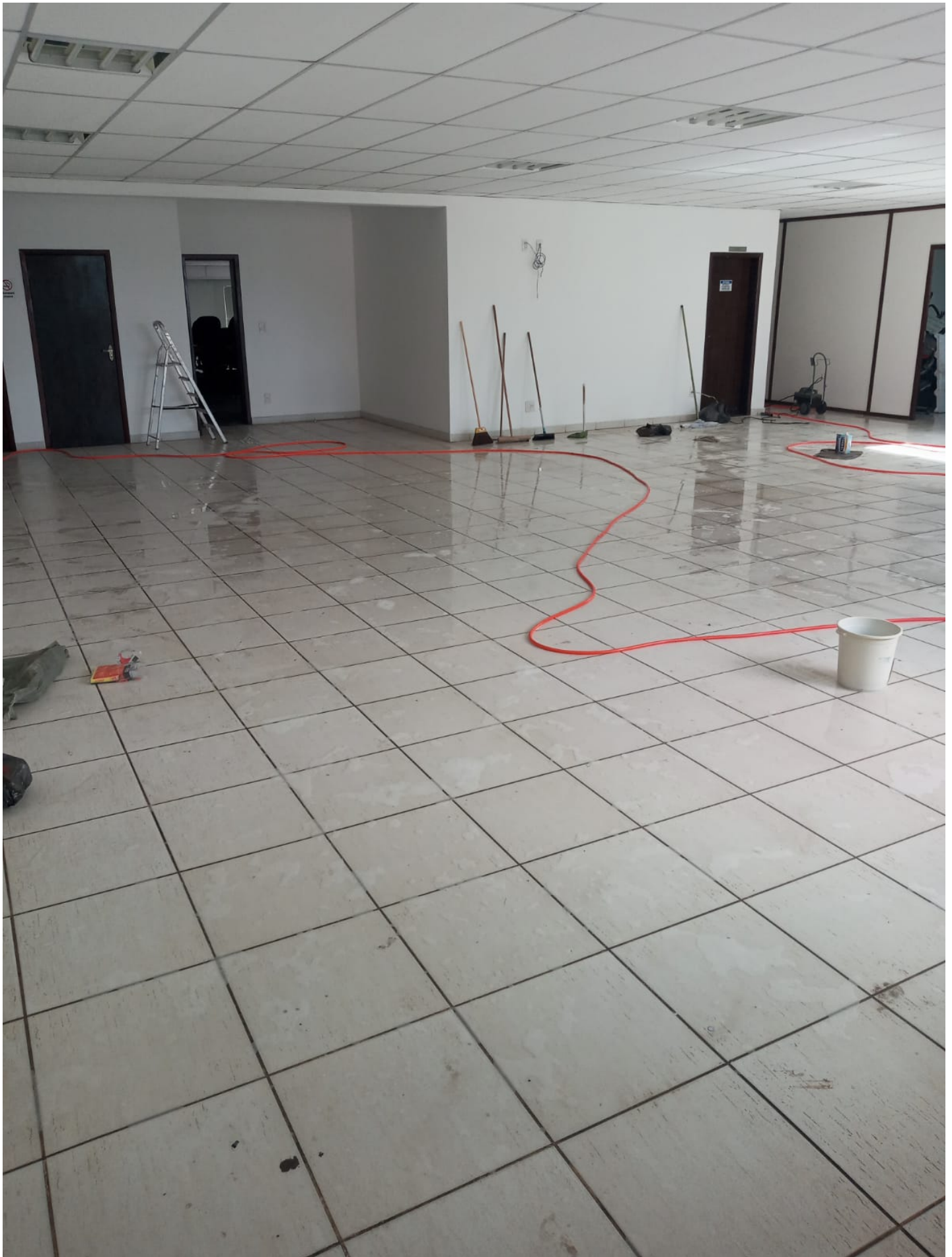
limpeza final da obra
