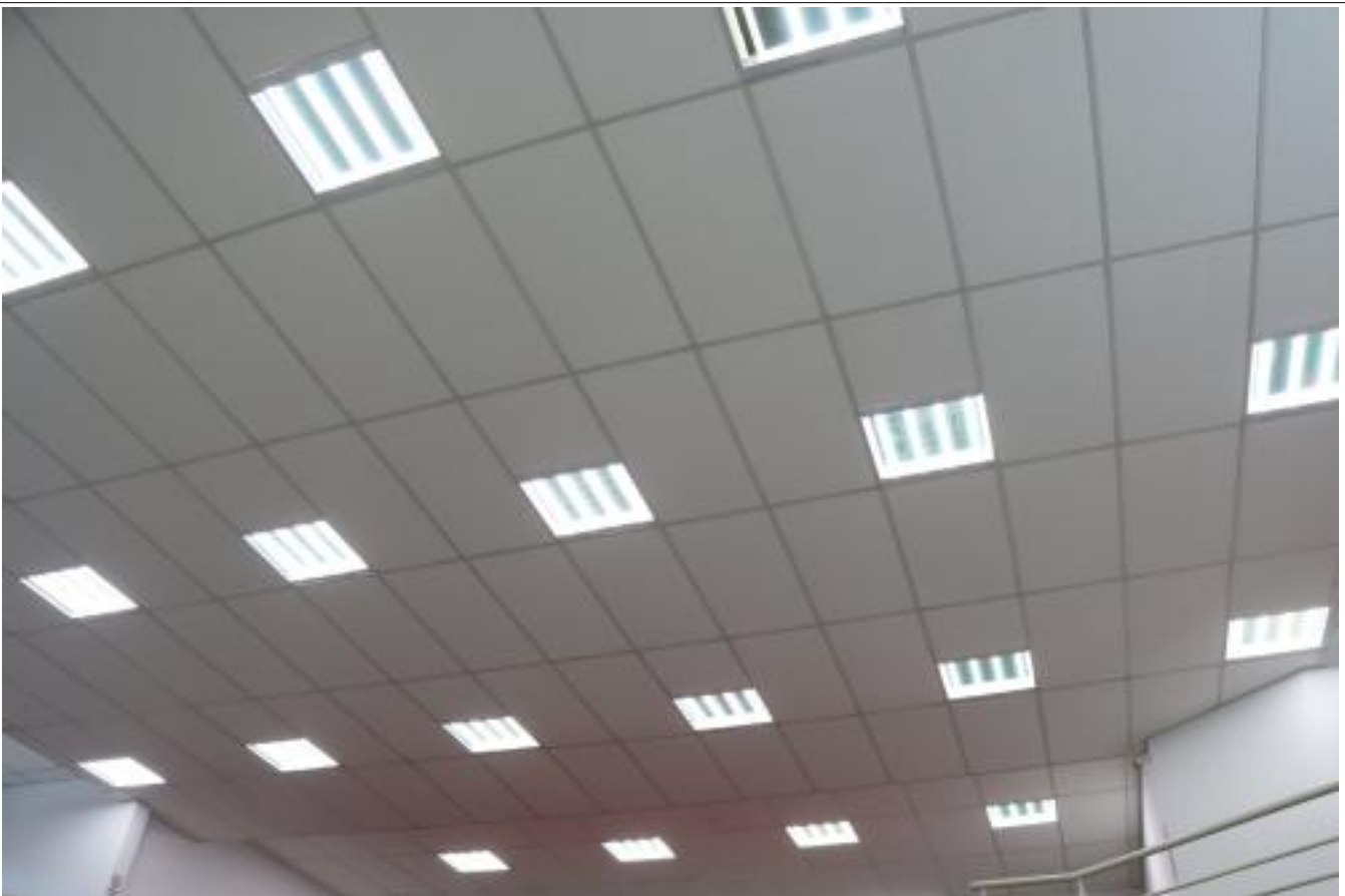
forro de isopor e luminárias
