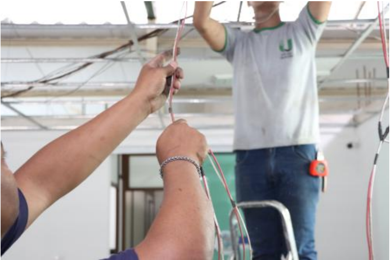
remocao de cabos eletricos
