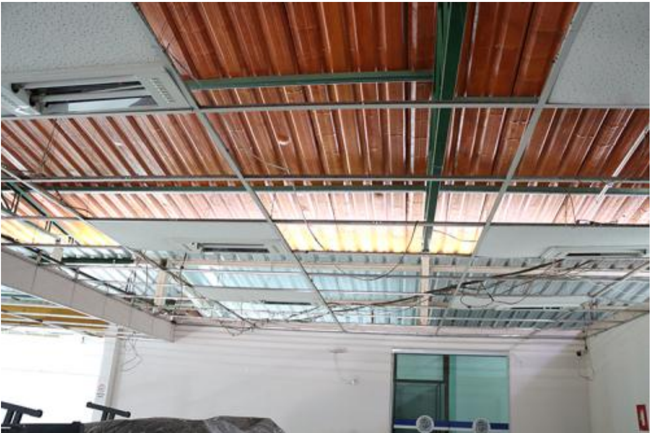
Retirada de forro 2
