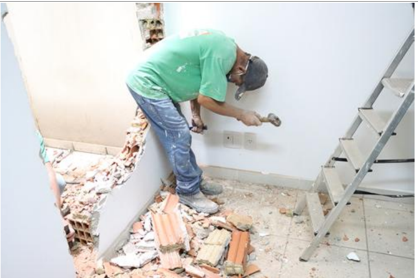
Demolicao de parede
