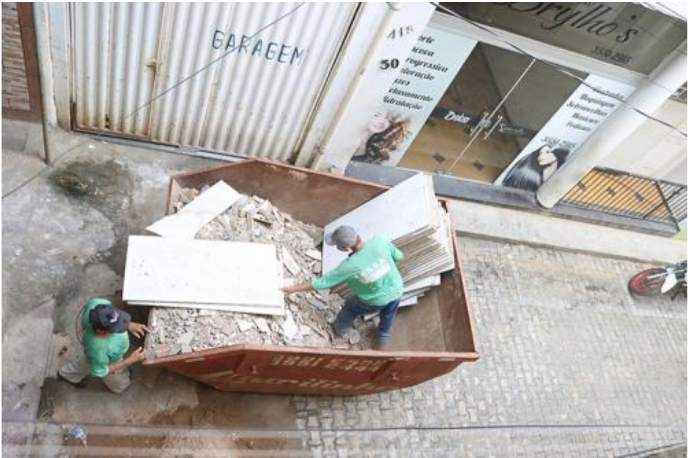
Retirada de entulho
