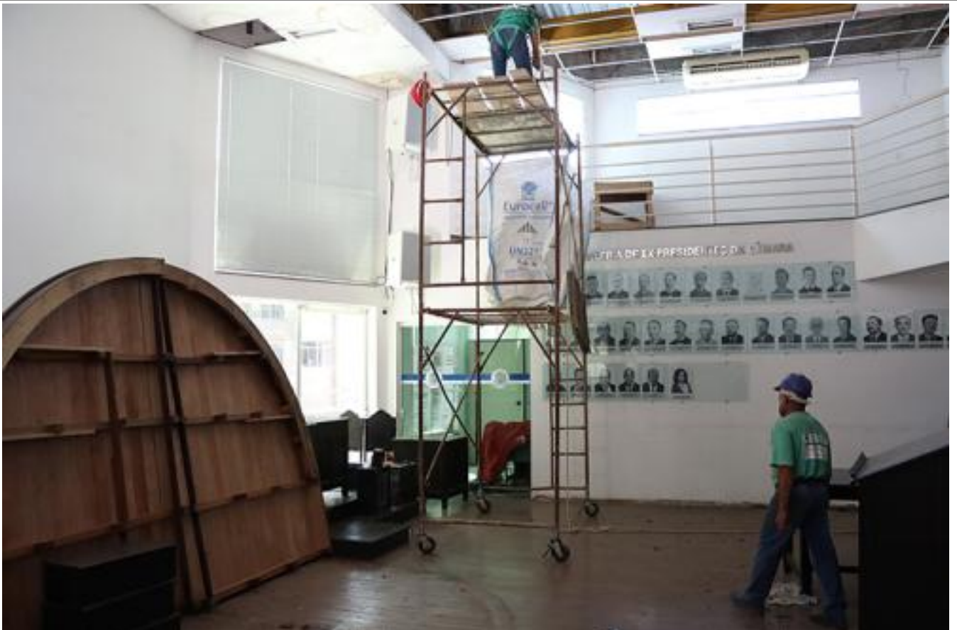
Retirada de Forro
