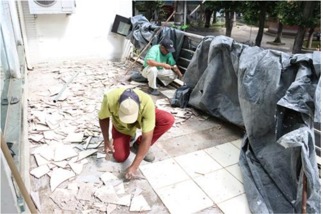
Retirada de piso
