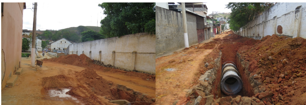
Melhorias na drenagem e infraestrutura da Rua Diogo Braga
